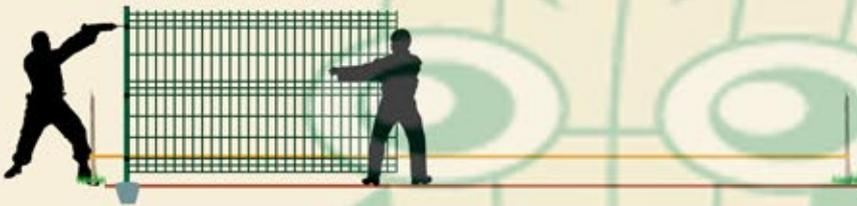
Fissare il pannello al palo con le piastrine in polipropilene e le viti. Per la posa delle piastrine utilizzare un avvitatore e non lasciare il pannello a bandiera per non compromettere la posa del palo.
